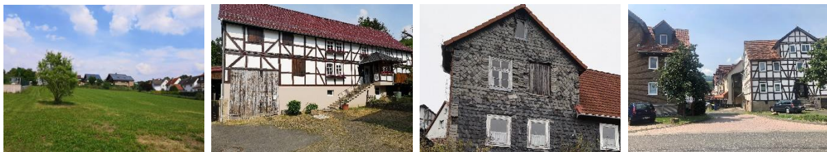
Abb. 59 Nachverdichtungspotenzial, Wohn- / Wirtschaftgebäude, Sanierungsbedarf und Ortsansicht
