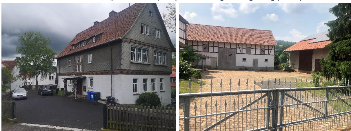
Abb. 29 Einzelkulturdenkmäler „Alte Schule“ (links) und Hofanlage im Hilgenweg (rechts)
