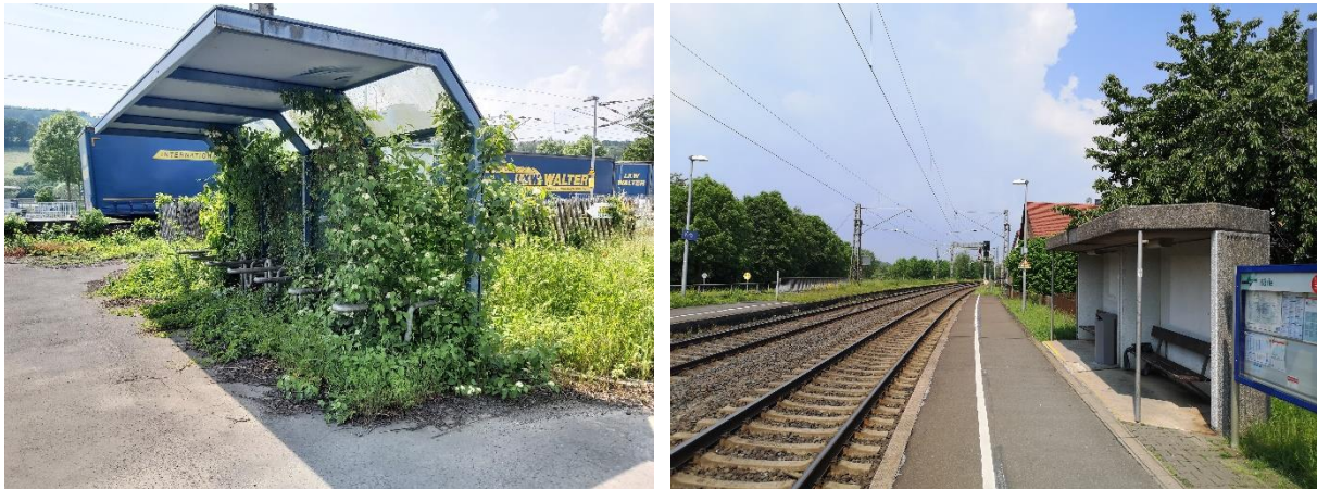
Abb. 54 Fahrradstellanlage im Bereich Bahnhofstraße (links) und Wartebereiche am Gleis (rechts)
