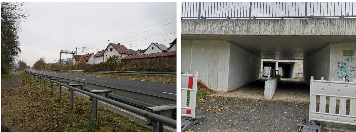
Abb. 35 Bundesstraße B83 und Bahntrasse (links) und Unterführung (rechts)
