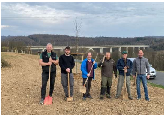
März: Beim Aktionstag helfen rund 30 Einwohner an fünf verschiedenen Baustellen
