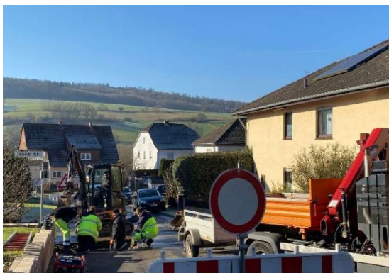
Januar: Arbeit für den Bauhof bei einem Wasserrohrbruch
