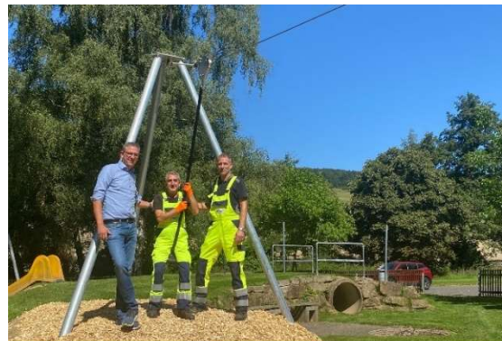
August: Neue Seilbahn für den Spielplatz Empfershausen
