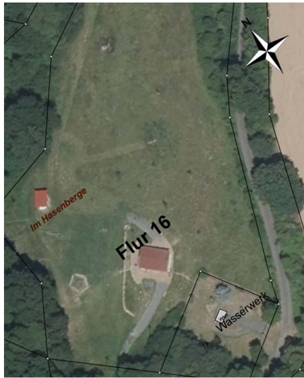
Errichtung der Schutzhütte. Herstellung von Betriebsflächen Stand: 2020
